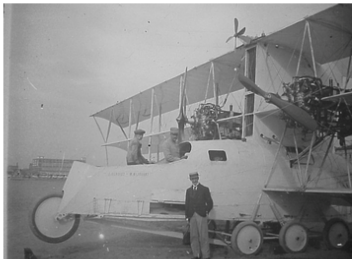
L'avant de l'appareil. Au dessus de la cheminée, la génératrice qui causa quelques ennuis lors du premier vol
