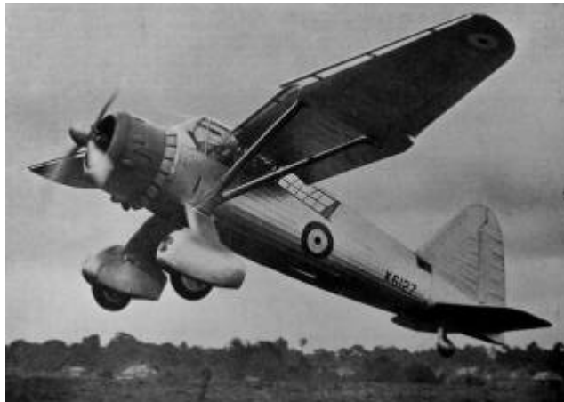
Le prototype au décollage. Notez les becs de bord d'attaque et les volets
