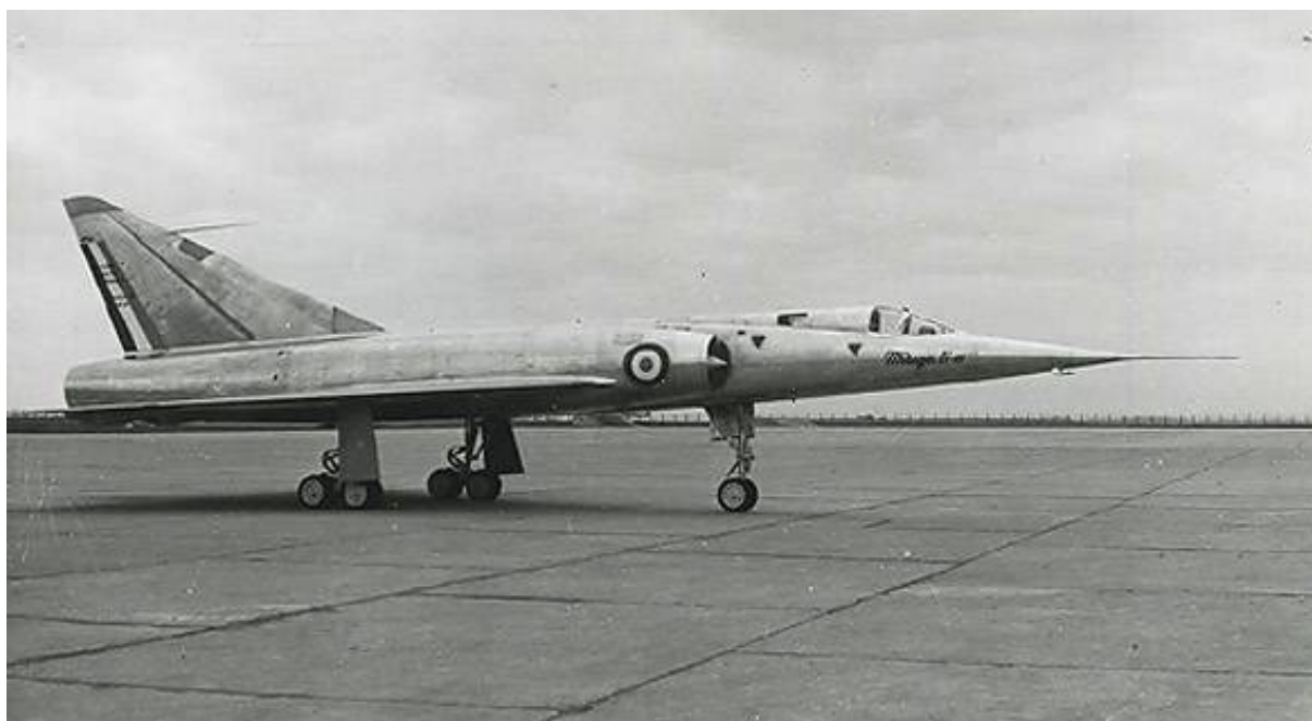
Le Mirage IV 001, première configuration, avec la dérive haute (Coll. R de Narbonne)
