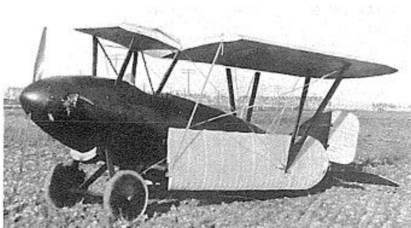
Loughead S1. On note les ailes repliables et l'aile inférieure qui pouvait servir d'aérofrein
